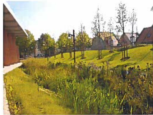
Figure 2 : Exemple de noue d'infiltration n°2
