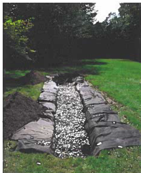
Figure 1 : Exemple de tranchée d'infiltration
