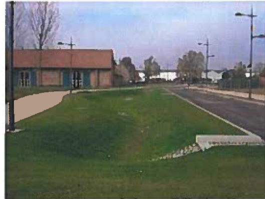
Figure 1 : Exemple de noue d'infiltration n°1
